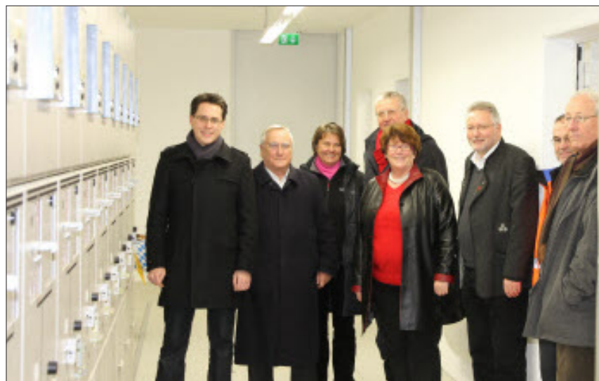
Mehrere Aufsichtsräte der Stadtwerke waren bei der Inbetriebnahme dabei: (v.l.) Dr. Christian Moser, Gerard Zacher, Renate Franzel, Wolfgang Lorenz, OB Anna Eder, Stadtwerke-Geschäftsführer Franz-Josef Krempchen, Siegfried Riesinger, Technischer Leiter der Stadtwerke, und Karl-Adolf Pfestorf. – F.: dz
